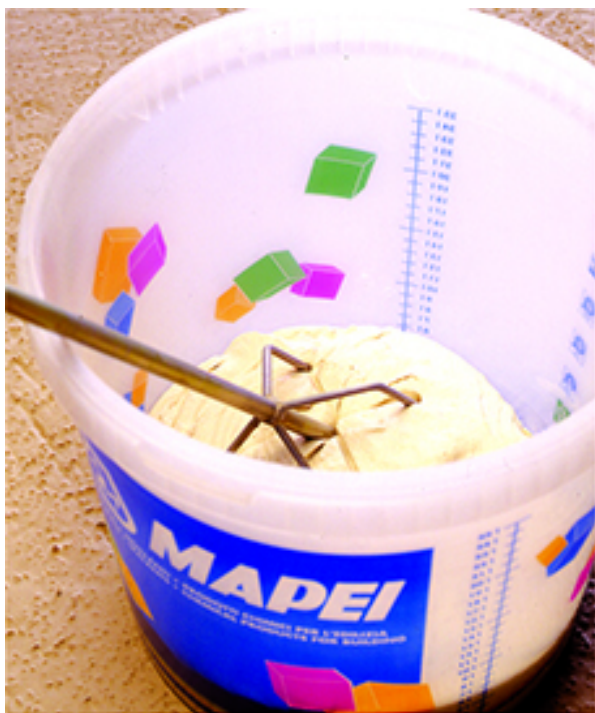
Mezcla de Mapeiset con agitador mecánico
