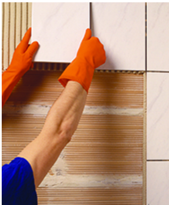
Colocación en pared de revestimiento cerámico
